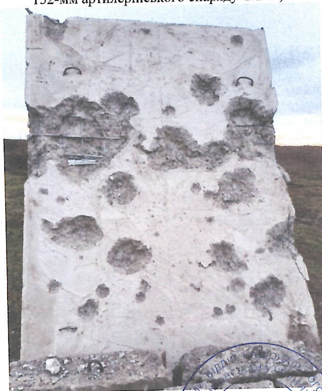
Залізобетонний елемент швидкоспороджуваної захисної споруди цивільного захисту модульного типу після випробувань (сторона підриву 152-мм артилерійського снаряду ОФ45)
